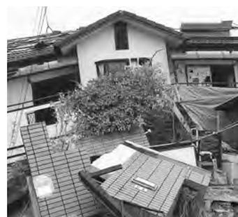
地盤が崩れ倒壊した住宅
