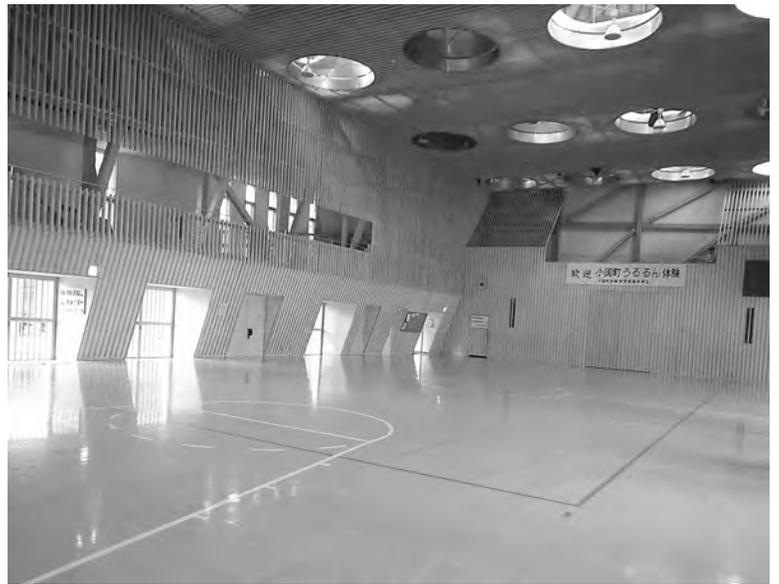
つづいて、日本最大規模を誇る木造建造物小国ドームに移動しました。こちらも小国町教育委員会職員の案内で内部まで見学を頂きました、1988年竣工、設計は葉 祥栄によるもので、日本建築学会賞等の受賞された経歴の方です。構造は木造立体トラス造、一部鉄筋コンクリート造は地元産杉材を天井トラスに使用し外観は巨大な亀の甲羅のようにみえることからビクタートルの愛称で親しまれているようです、大きさと建物の素晴らしさに全員が感動していました。小国町教育委員会に感謝をいたします。
