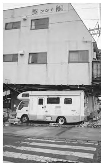
そこから県道28号線の南側地域へ。このエリアは特に被害が大きく、道の両側に倒壊や全壊住宅が連続していた。その中で、最新の耐震基準で建てたにも関わらず1階部分が崩壊した住宅を見てみると、偶然に彼女の仕事関係の知人が来た。何をするのかと聞くと、施主が全壊した住宅の原因調査を依頼したため、残った部分の整理や足元の片付けに来たとのこと。この地域は、震源断層のほぼ直上に位置していたため震度7が観測されているが、それだけでは納得できない思いが施主にはあるのかもしれない。
